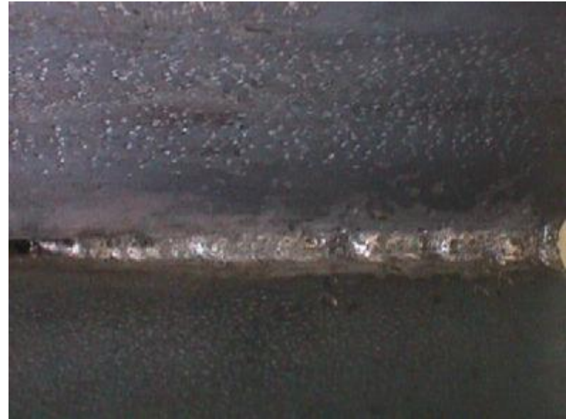
Solda com penetração deficiente
