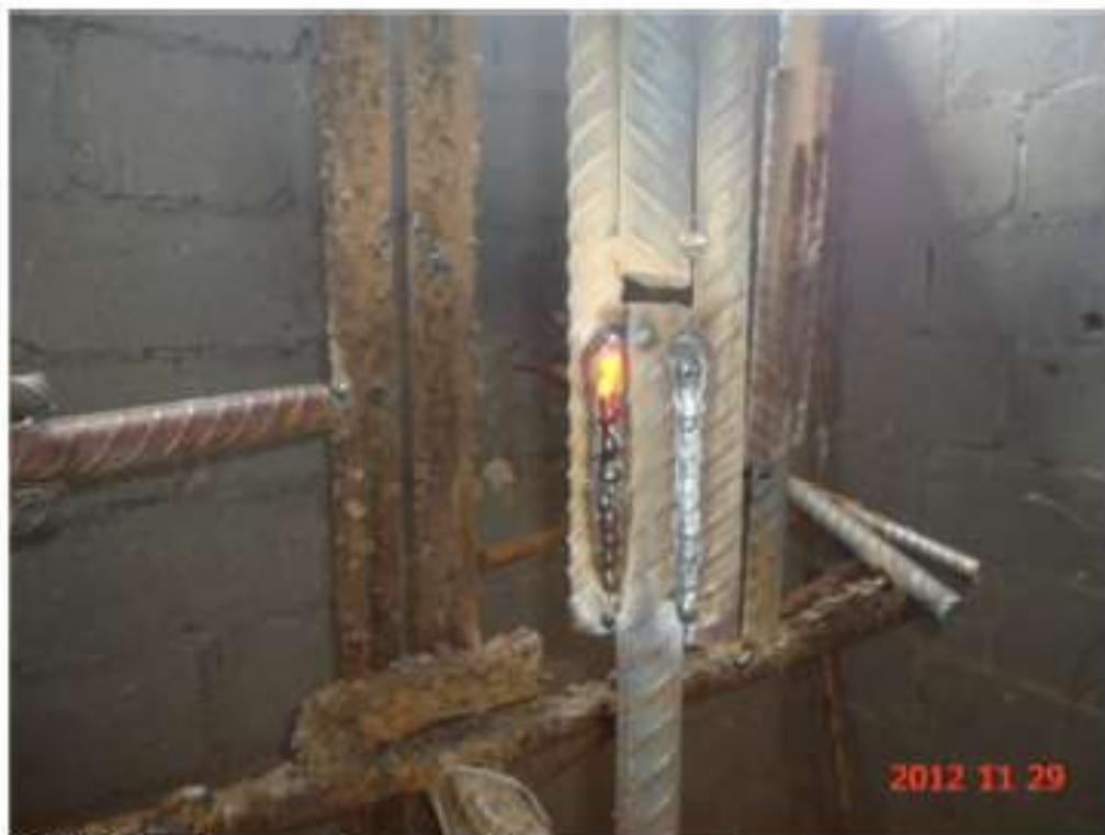
*Solda de acabamento do corpo de prova.*
